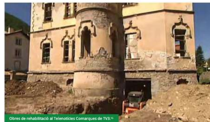
Obres de rehabilitació al Telenotícies Comarques de TV3. 15
